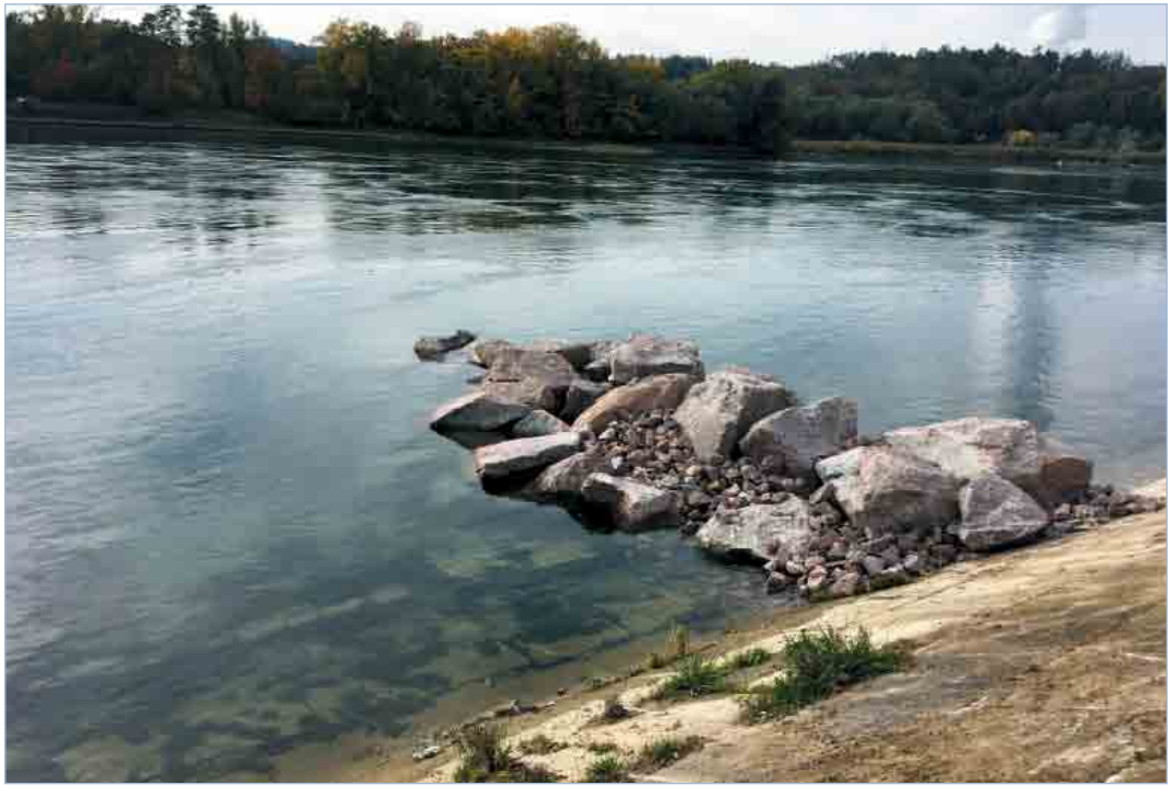
Beispiel aus Wasser ragende Steinbühnen auf Betonplatten (Axpö)
